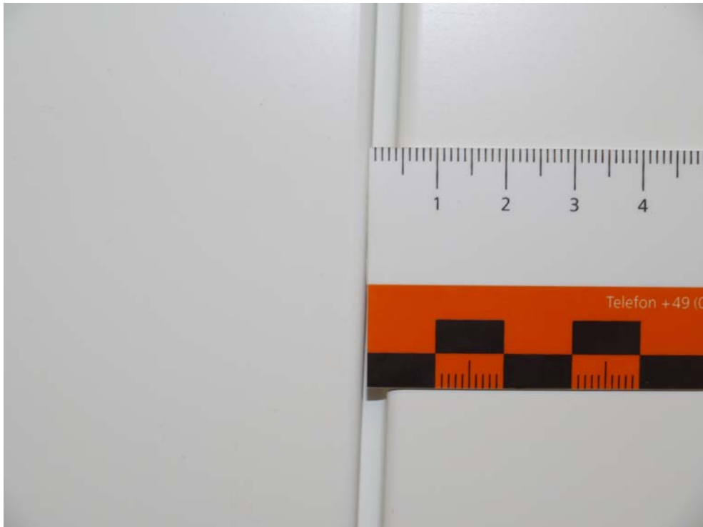
Abbildung B.3 Ansicht Elementfuge des Prüfaufbaus
